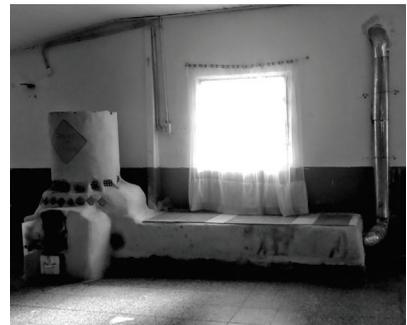
*En el ejemplo aquí presente se resolvió la cañería a la vista, sin embargo se recomienda revestir la chimenea para evitar posibles quemaduras y, además, dotar al sistema de un aspecto estético personalizado.*
