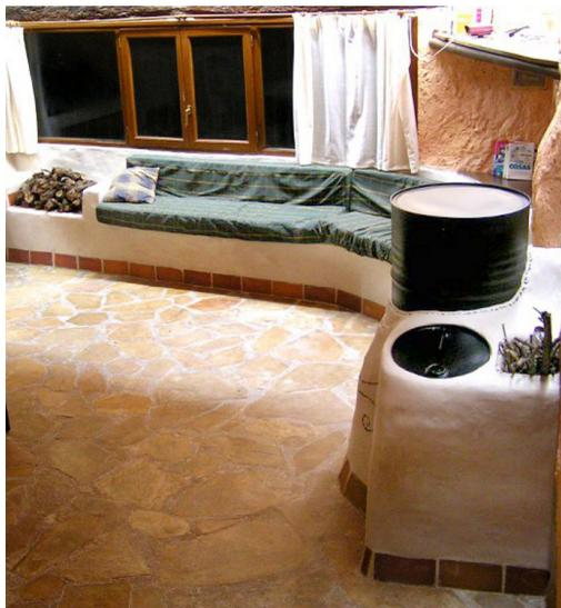
Si bien existen muchas opciones constructivas, hay dos modelos básicos a nivel técnico. Aquí se describe el modelo llamado "L", por la forma de su cámara de combustión y tipo de alimentación de la leña, que se adapta a usos en una vivienda familiar, con carga por el interior, lo que aumenta aún más la facilidad de limpieza de estas estufas.
