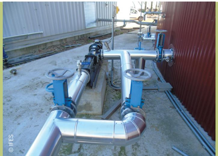
El otro tipo de bombas empleadas en biodigestores son las de desplazamiento positivo o alternativo. Estos equipos operan con el principio de entregar un desplazamiento positivo a la vena fluida, en uno o varios cuerpos de la bomba. Permiten mover sustratos con altos contenidos de sólidos y mezclar materias primas sólidas con líquidos. En esta categoría pueden distinguirse las bombas de pistón, las lobulares (Imagen 27) y las de tornillo (Imagen 28).
