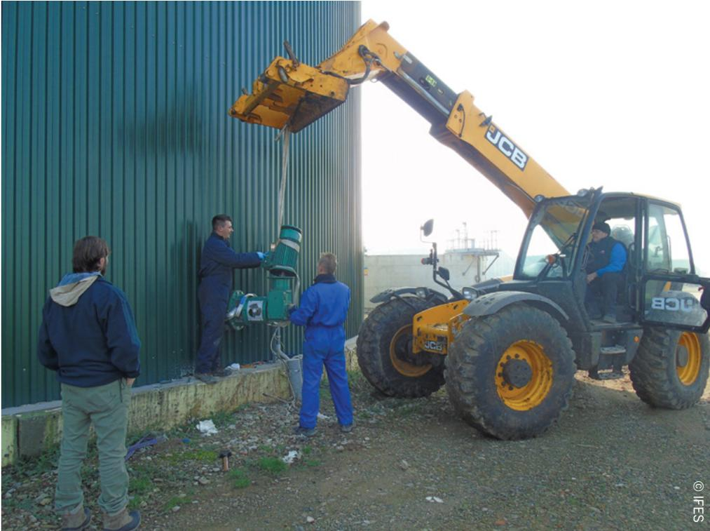
**Imagen 25.** Vista externa de agitador horizontal en muro de biodigestor
