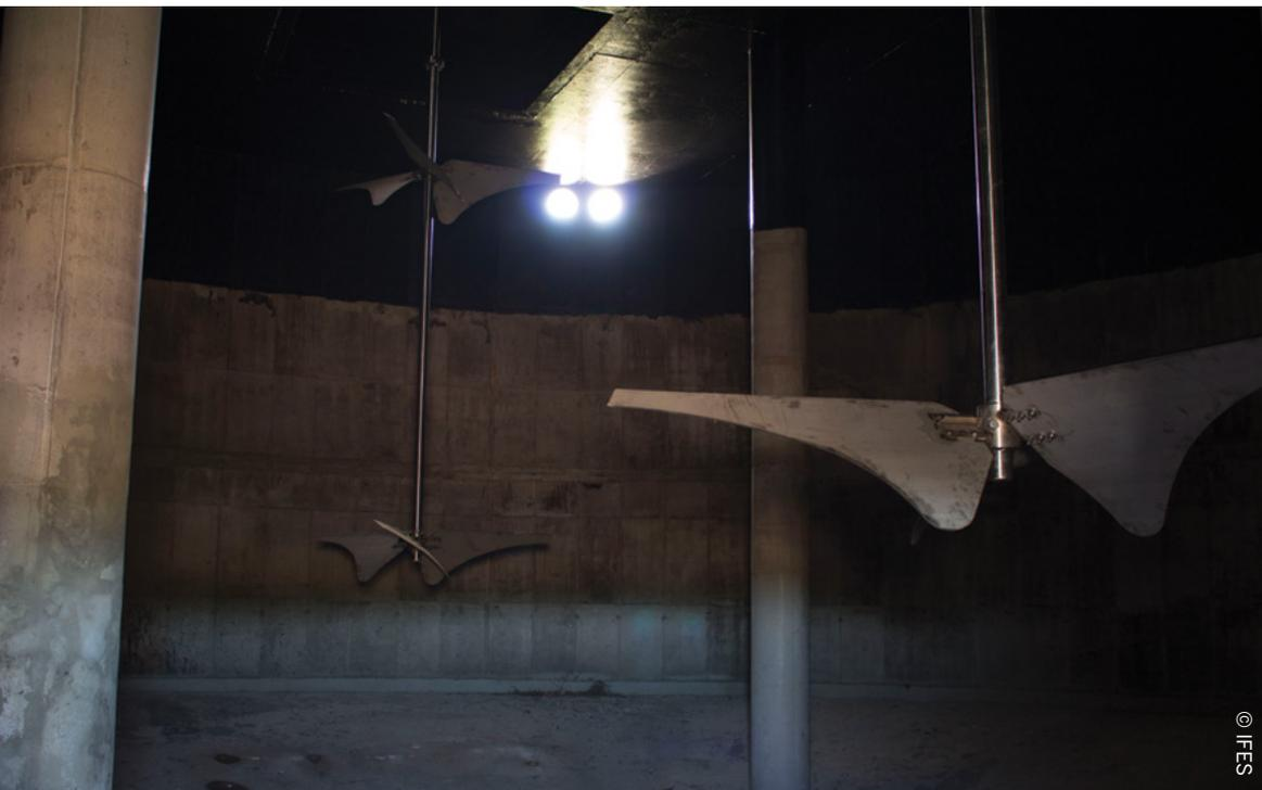
Los métodos y sistemas para garantizar movimientos dentro del biodigestor van desde los más sencillos, que principalmente aprovechan características propias del diseño sin necesidad de utilizar energía extra o sistemas mecánicos, hasta grandes bombas de recirculación y sistemas de agitación continuos que logran una mezcla completa.
