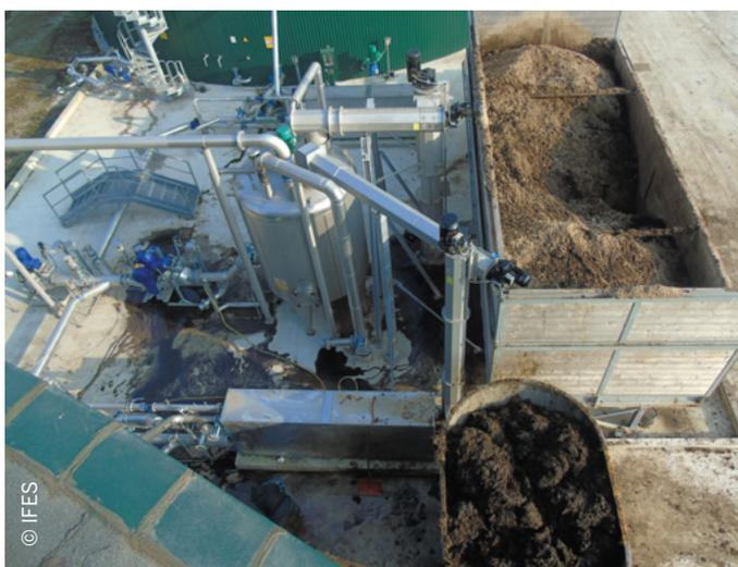
**Imagen 24.** Sistema de limpieza de FORSU, pretratamiento para envío del sustrato a tanque de precarga
