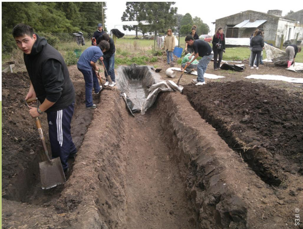
Imagen 31. Instalación de biodigestor tubular
