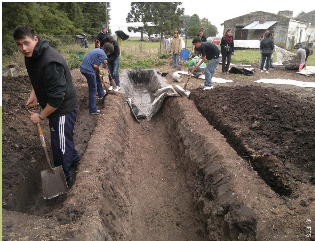
Imagen 31. Instalación de biodigestor tubular
