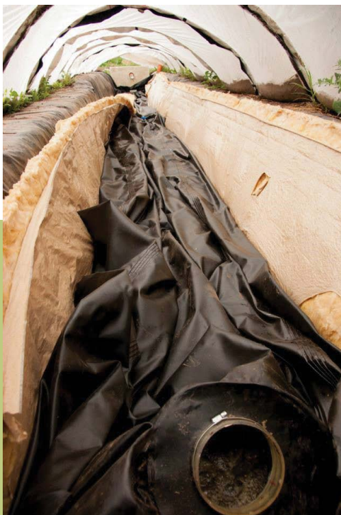
Imagen 33. Biodigestor tubular con aislante de lana de vidrio
