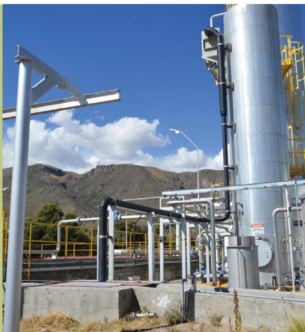
Imagen 6. Reactor UASB
