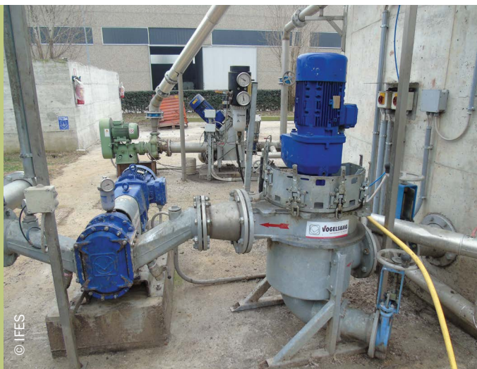
Imagen 21. Sistema de trituración en cámara de premezcla
