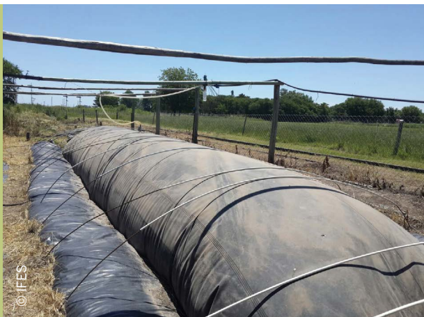
Imagen 2. Biodigestor construido con membrana de PVC
