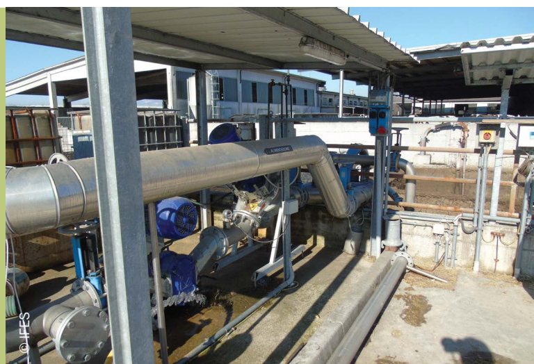
Imagen 20. Cámara de carga de biodigestor en tambor estabulado
