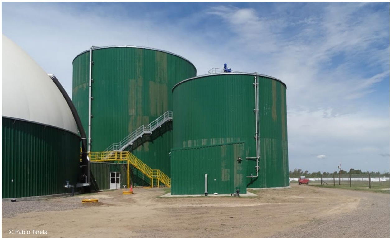
Imagen 3. Digestores en secuencia en una planta de biogás
