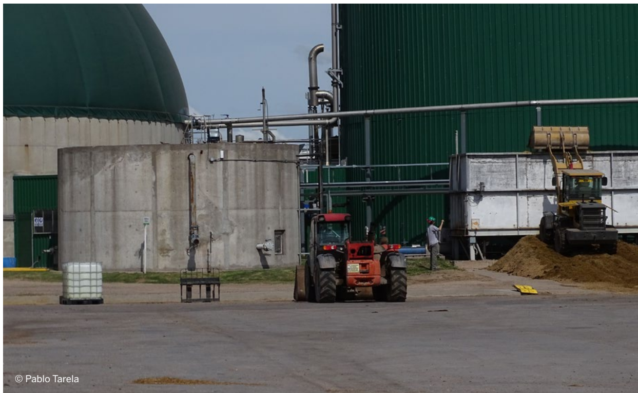
Imagen 2. Tanque de recepción y almacenamiento de residuos ganaderos en planta de biogás
